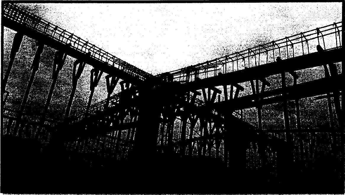
ACERO ESTRUCTURAL DE VIGAS Y ENCOFRADO
