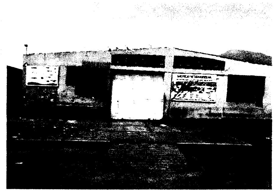
Vista. 01. La estructura antes de su demolición.
